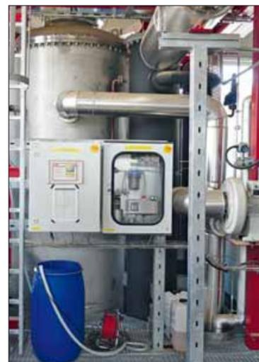
System zur Abscheidung der Kondensate: Das Gas wird permanent analysiert (rechter Kasten im Vordergrund).
