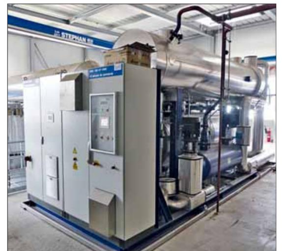
Ein ORC-Modul von Dürr verwertet die Wärme, die in den Rauchgasen aus der Brennkammer enthalten ist, direkt, ohne Thermoölkreis – eine Besonderheit der Anlage in Puidoux.
