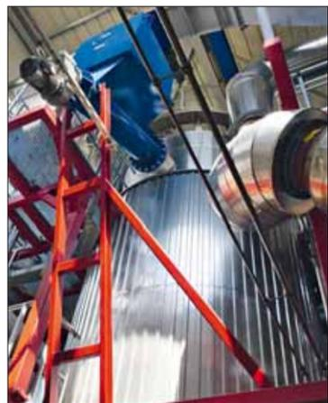
Der Festbett-Gegenstromvergaser ist 9 m hoch und hat einen Durchmesser von 2,8 m. Er wird von oben befüllt; blau zu erkennen ist der Zwischenbehälter für die Hackschnitzel.
