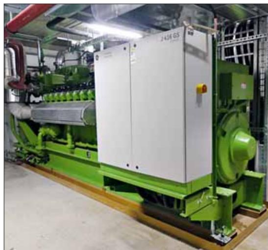
Die motorische Nutzung des aufbereiteten Holzgases erfolgt in einem BHKW mit Jenbach-Gasmotor. Dessen Abgase werden in der Brennkammer nachverbrannt.
