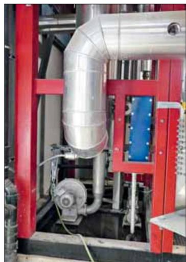
An diesem Bereich u. a. mit dem Gebläse für die Vergaserluft ist der modulare Aufbau der Anlage gut zu erkennen.
